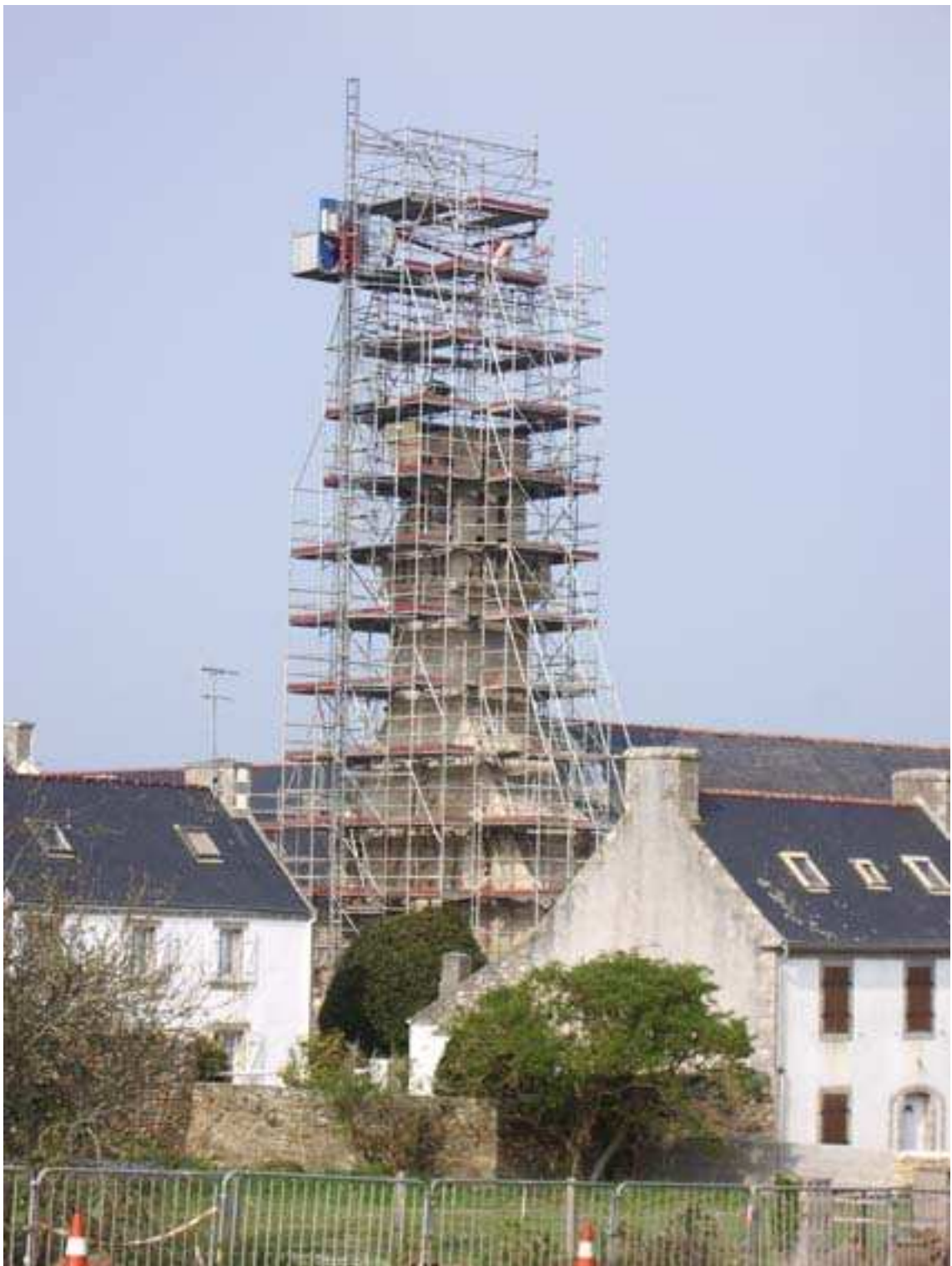
Clocher en réparation 2008
