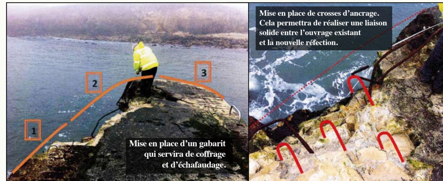
Mise en place de crosses d'ancrage. Cela permettra de réaliser une liaison solide entre l'ouvrage existant et la nouvelle réfection.
