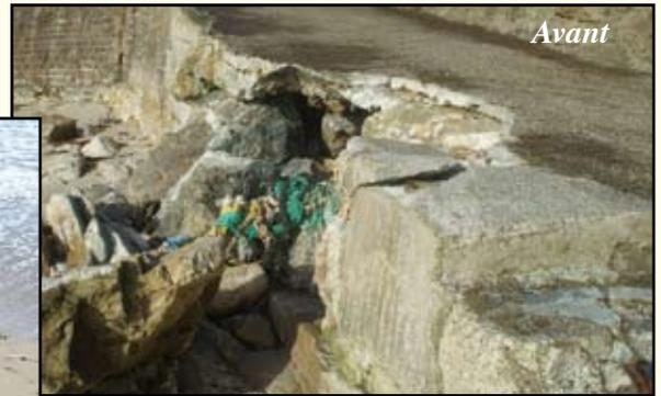
Les tempêtes du début de l'année ont gravement endommagé la cale du Loch. Après avoir constaté l'ampleur des dégâts nous avons fait appel à l'entreprise SPAC de Chateaulin, spécialisée en travaux maritimes. La réparation a nécessité la pose d'un impressionnant ferrailage et l'injection de 9 m<sup>3</sup> de béton pour combler le trou.
